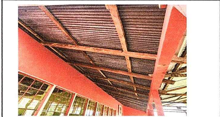
Foto 1: Sustitucion de estructura de madera en mal estado
