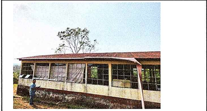
Foto 2: Sustitucion de laminas en mal estado
